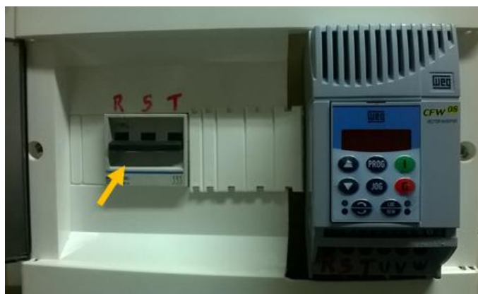
Figura 2.11. Posicionamento da chave que deve ser acionada.
